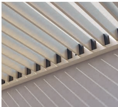
TR4520 Montering i dörrar/fönster
